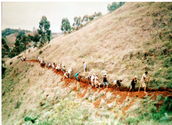
Creusement de la canalisation à flan de colline
