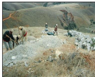
Assèchement et bétonnage du bassin de rétention. Les casseurs de pierre fabriquent les moellons et les graviers à la main.
