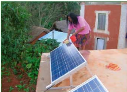
Nettoyage des panneaux solaires.
