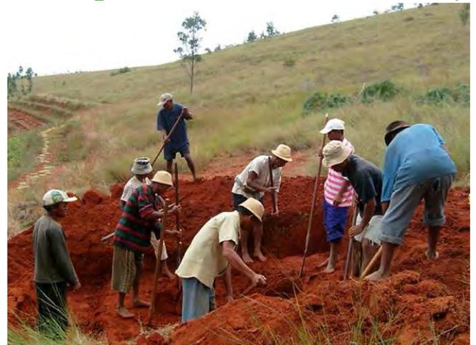
*Le début des travaux : les pieds dans la gadoue ! Le creusement des fondations du château d'eau avec les angady (bêches) et à la force des bras !*
